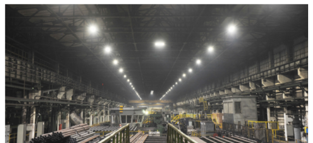
Новые светодиодные светильники в трубопрокатном цехе
